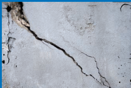
ひび割れ監視
