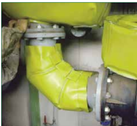
マジックテープにて施工
