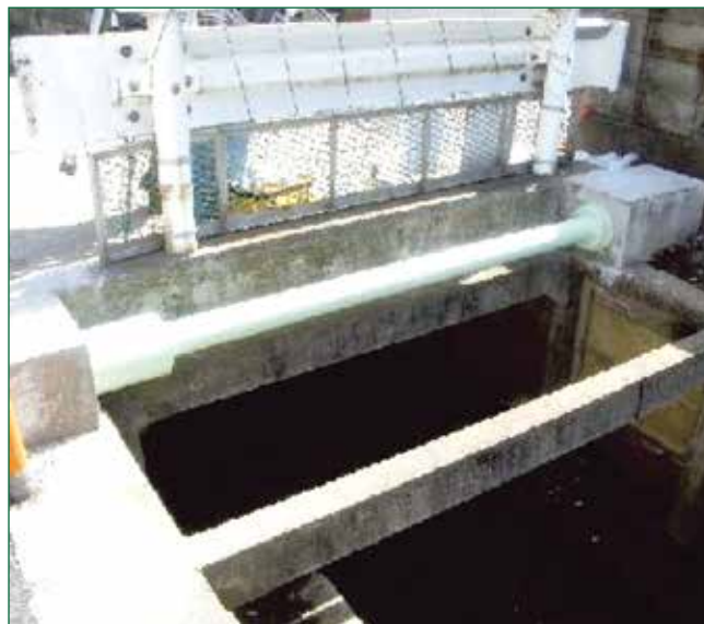
既設ガバナ設備施工例（結露による腐食対策）
