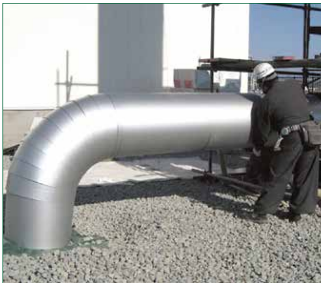
防音外装板施工例（配管用）
