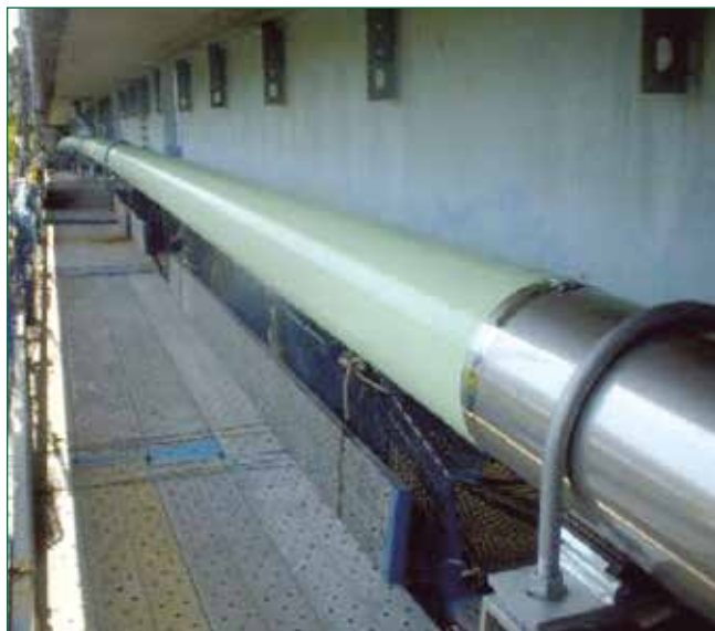
新設バルブステーション絶縁フランジ施工例
